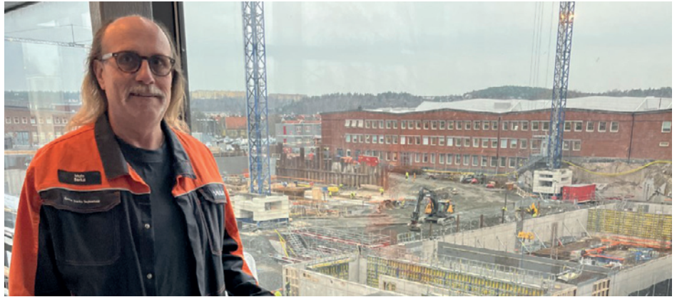
Mats Berius framför den nya byggnaden för EL-Drivlineutveckling. Här ska det arbeta flera hundra personer när den är färdigbyggd. Ett flertal av dem kommer att vara arbetare. Vågar man hoppas på ungdomar och mer tjejer i framtida verksamhet också?
